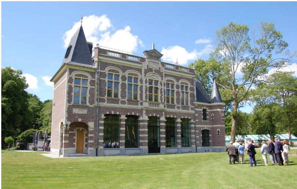
Het gerestaureerde gebouw waarin zich op het gelijkvloers de orangerie bevindt. Op de eerste verdieping is de Bibliotheca Elseghemensis ingericht en daarachter (niet zichtbaar op deze foto) het auditorium. Rechts op de achtergrond de grote tent (Foto : William Dehenau)
